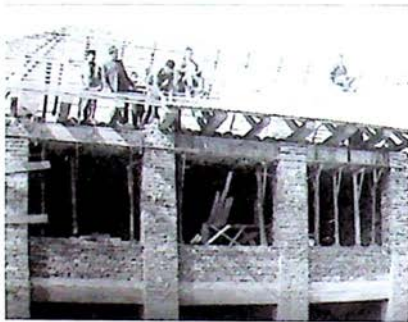
Az épülő óvoda
