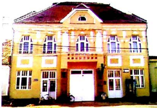
A karcfalvi kórház - Fazakas Jenő volt lakása
