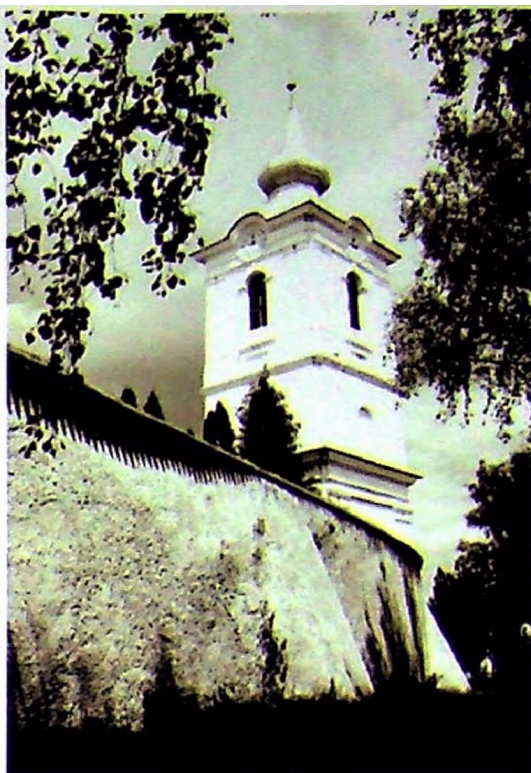
A vártemplom felújított tornya (1997, Dimény Attila)
