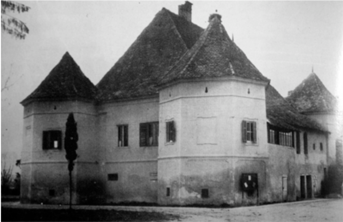
62. A kisbúni kastély oldalnézete és udvari homlokzata
