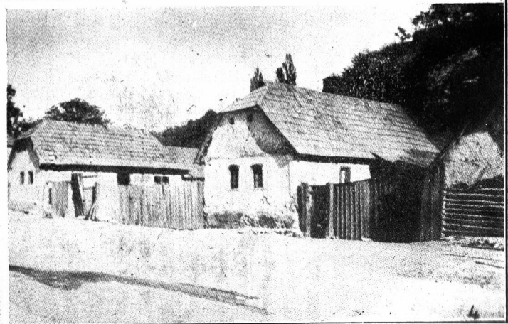
3. Kőkerítés, boltíves kapu, kerekas kút. 4. Csonkakontyos zsindeletető, deszkekakrítés, deszkekakapu.
