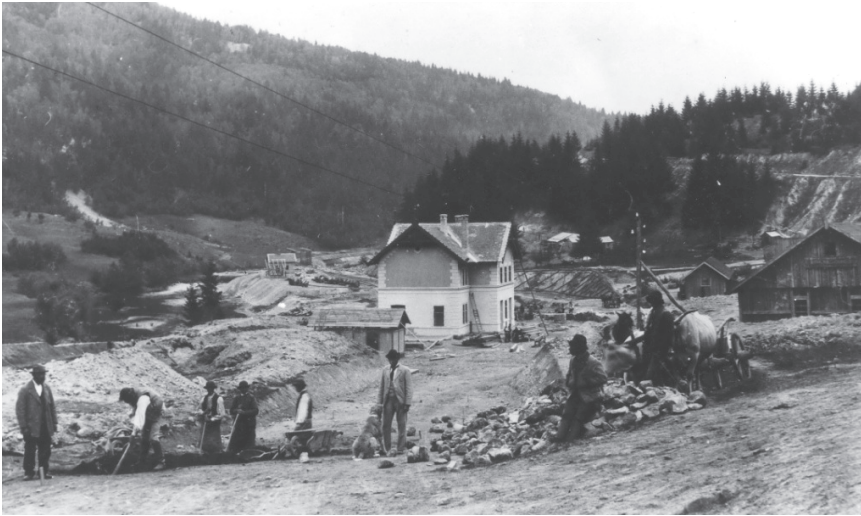
19. ábra. A Sepsiszentgyörgy–Csíkszereda vasút építése tusnádfürdőnél, 1896-ban. 407
