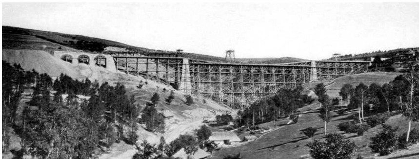
20. ábra. Csíkszereda–Gyimes vasútvonalon a Karakó völgyhid. 457
