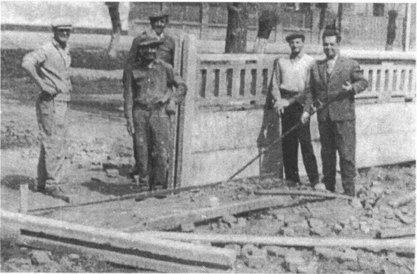
A közös iskola építése 1963–1964-es tanévben
