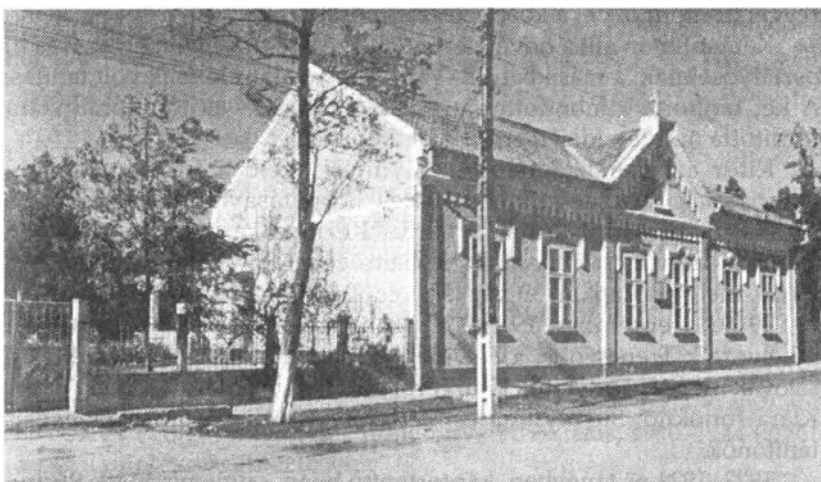
Az 1909-ben épült volt római katolikus leányiskola a zárdával
