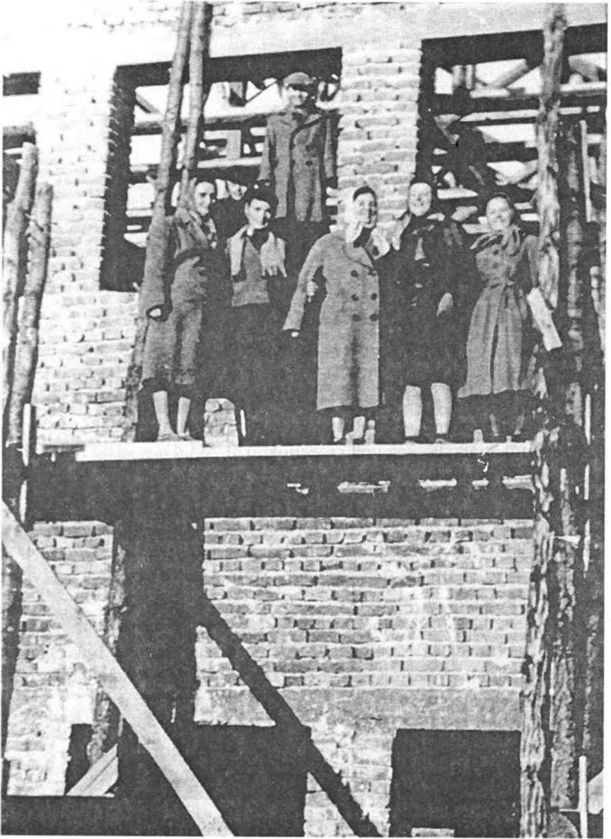
Az épülő kultúrotthon a 60-as években
