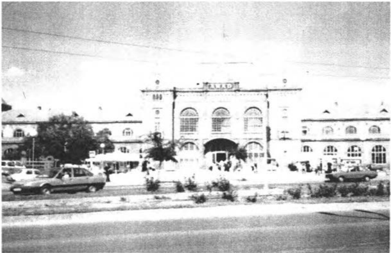
Az aradi vasútállomás épülete
