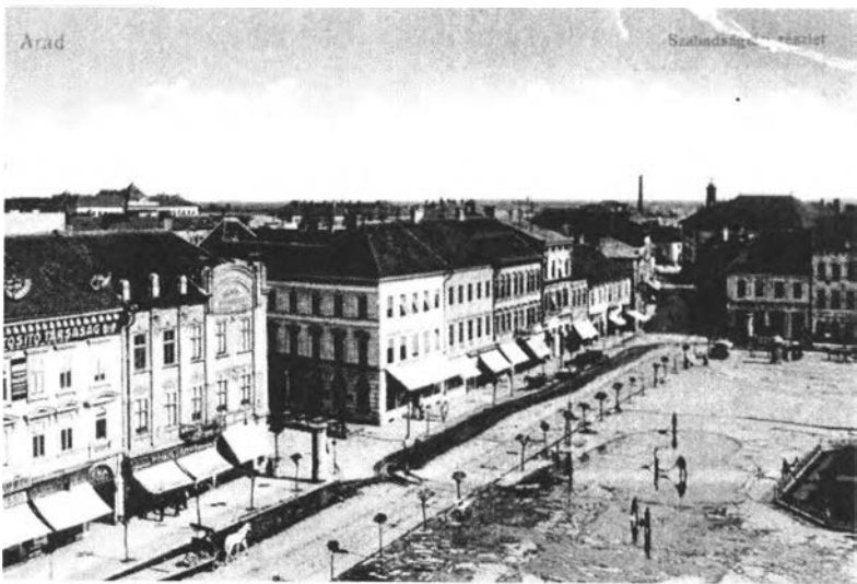
A Rozsnyay-áruház eredeti homlokzata egy régi képeslapon
