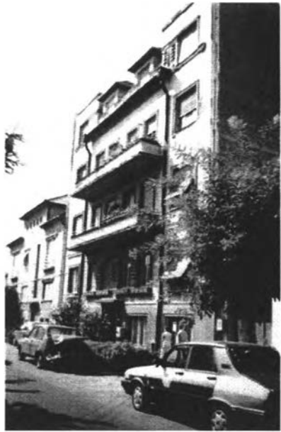
Lakóház a Coşbuc (Wesselényi) utca 15. sz. alatt
