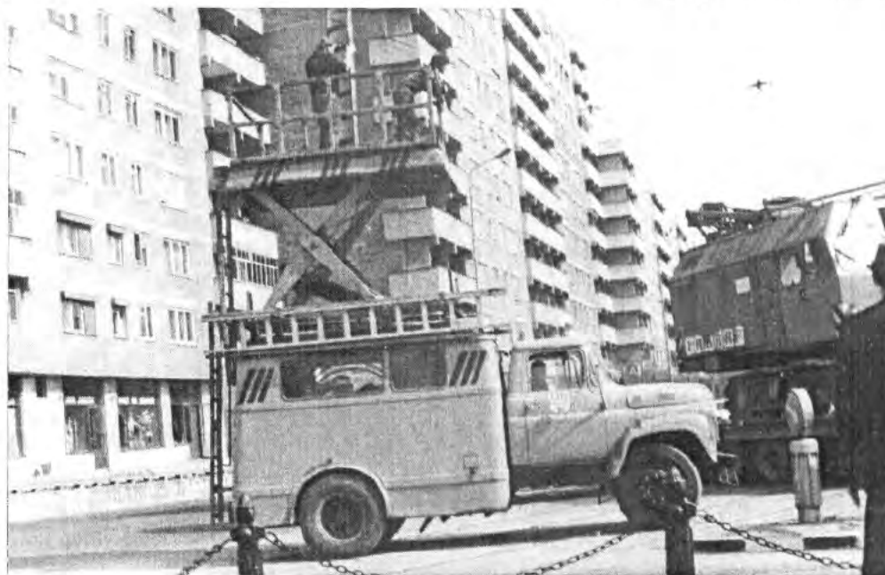
Tornyoskocsival emelik meg a felsővezetéket, hogy átférjen alatta egy daru – 1986
