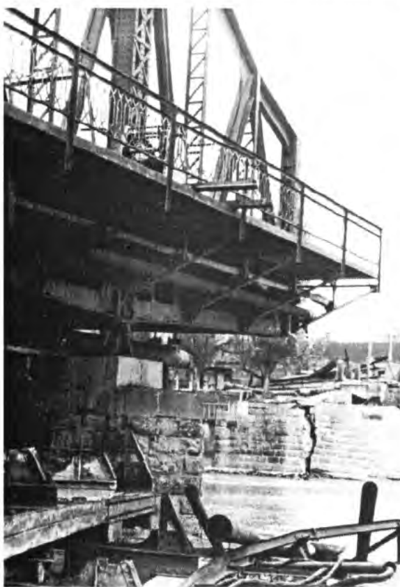
A Vitéz utcai vashíd bontása 1981 áprilisában, háttérben a kettétört pillér
