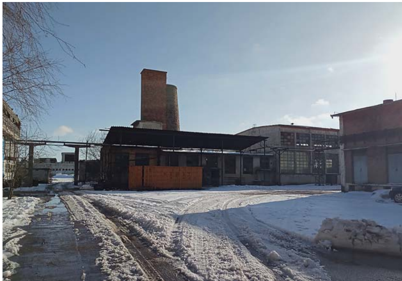
Hőközpont és kompresszorház
