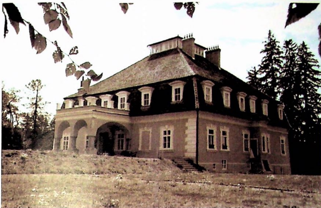
A Mikes kastély északi bejárata (2012, Pozsony F.)
