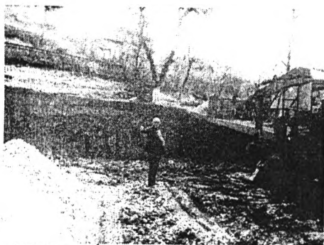
A Márton Aron Ház építése 1989-ben
