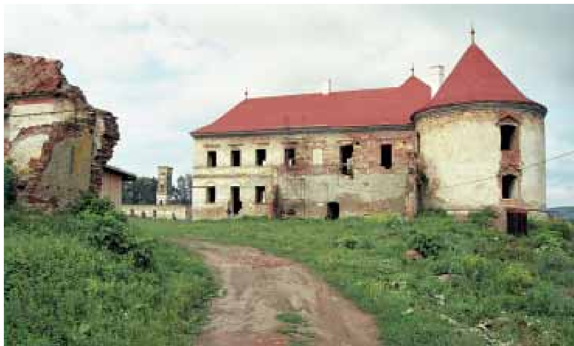
240. Bonchida. A reneszánsz főhomlokzat 19. században átalakított északi fele
