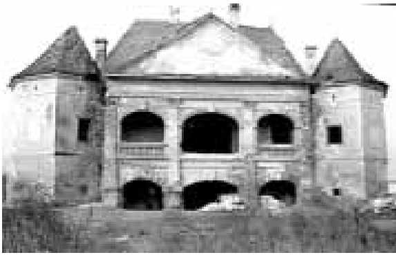
223. Kisbún. A kastély főhomlokzata. 1981.
