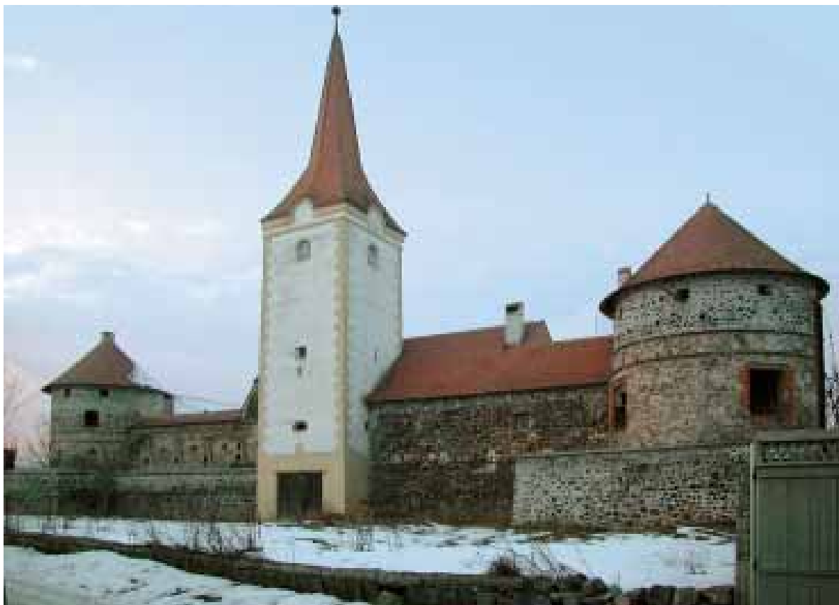
205 Alsórákos. A kastély főhomlokzata
