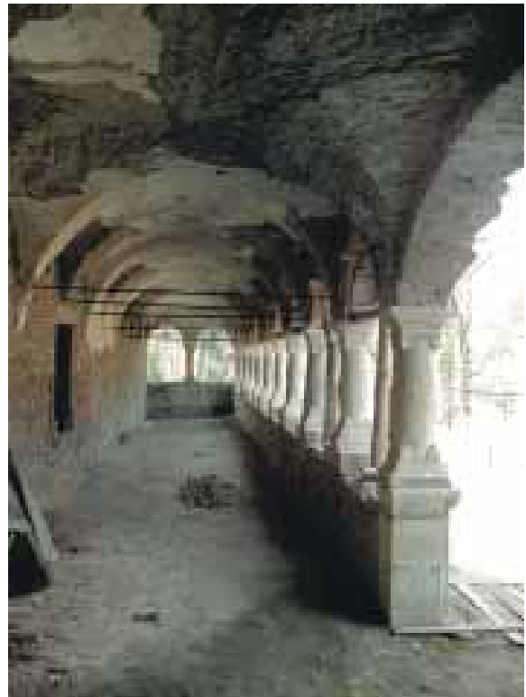
246. Keresd. A loggia
