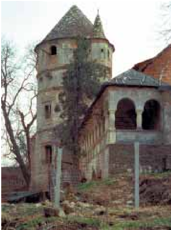
245. Keresd. A torony és a loggia az udvar felől
