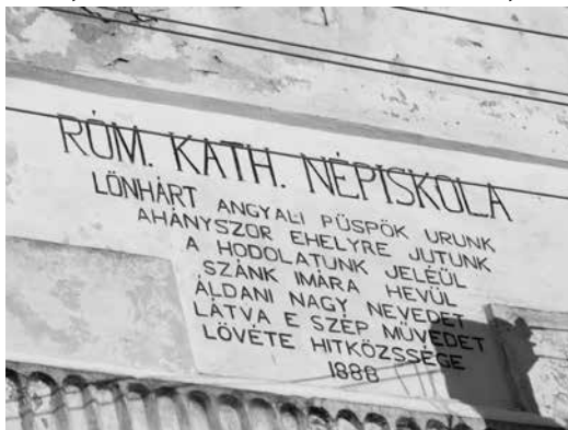
Az emlékfelirat az épület felújítás előtt
